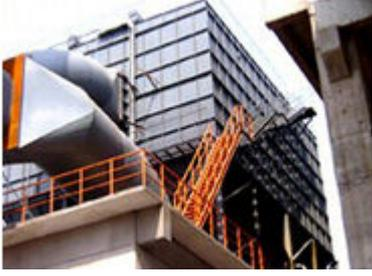
• GXCD 系列管状静电除尘器对粉尘直径>10 微米的在旋风除尘器中扑集<10
